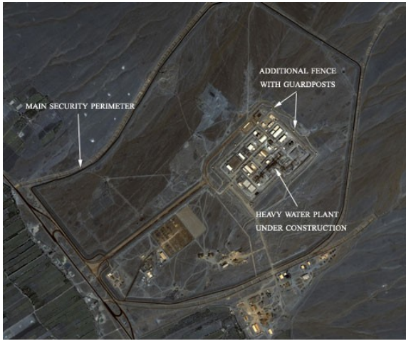
ARAK, IRAN -- SITE OVERVIEW
